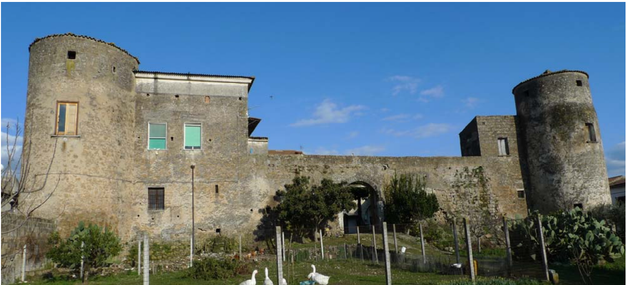
Figura 39. Il prospetto della cortina ovest verso il giardino, tra le due torri di NO e SO.
