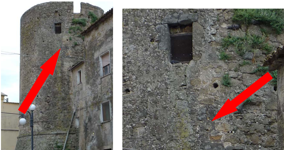
Figura 34. La torre mastio verso la cortina nord, la finestra e l'archibugiera (seconda metà del XV secolo).
