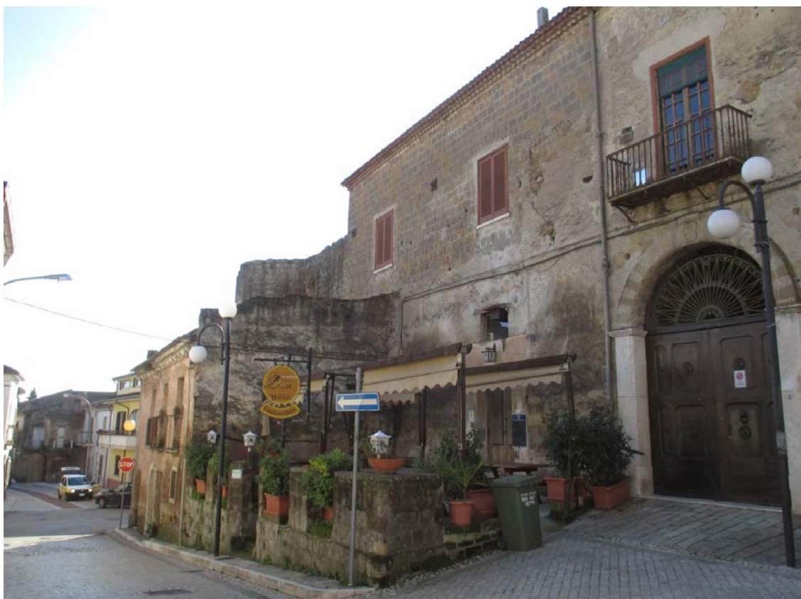
Figura 23. L'ingresso attuale al castello. La casa, addossata alle mura dal 1869 circa, maschera quasi completamente la torre SE. Si noti anche il dislivello tra la quota di accesso alla corte interna e la base della torre SE, che oggi probabilmente è alla quota di fondo del fossato che Meomartini afferma di aver visto a fine 1800.
