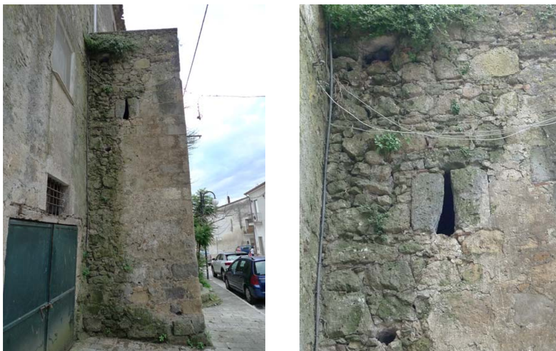
Figura 29. Fianco est della presunta torre al centro della parete nord e particolare della sua monofora.
