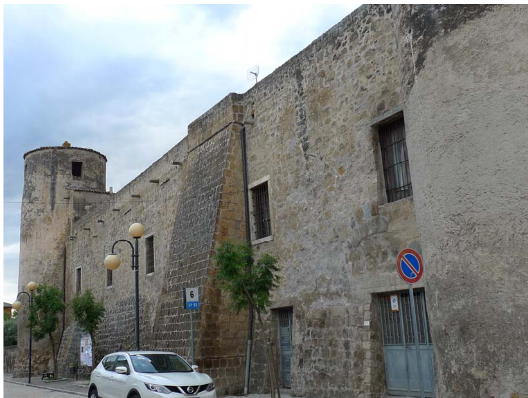
Figura 22. Il prospetto verso sud
