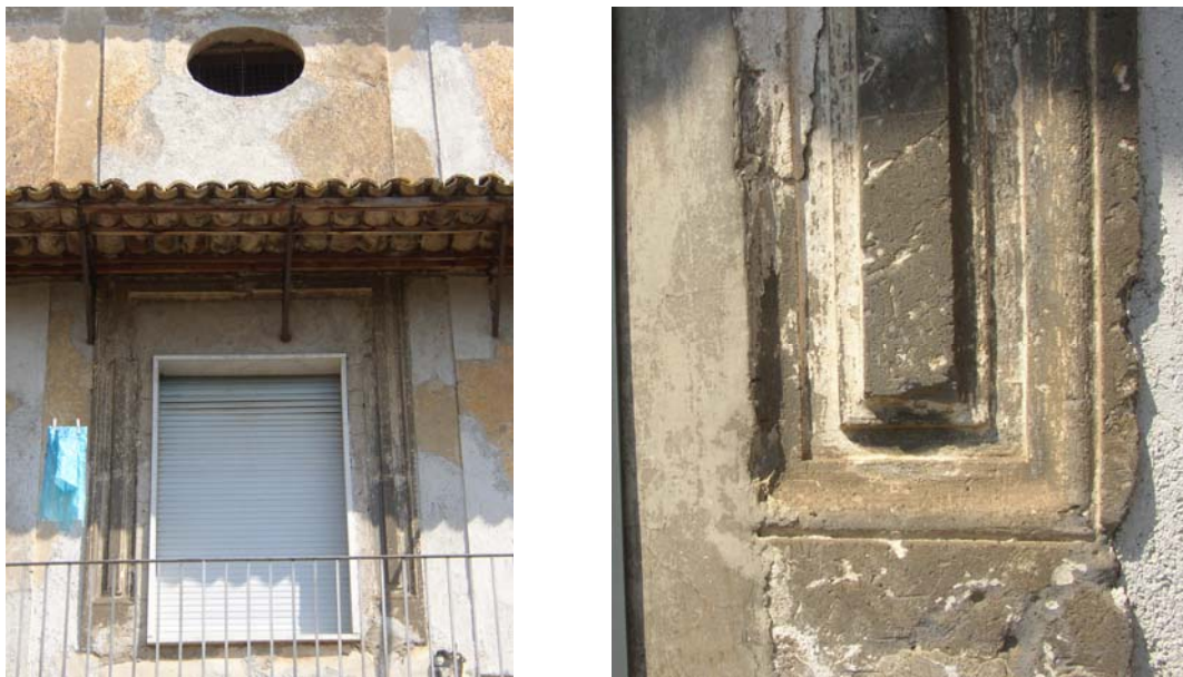
Figura 46. Una delle cornici tardomanieristiche delle finestre del piano nobile dell'ala palaziale antica e un particolare.
