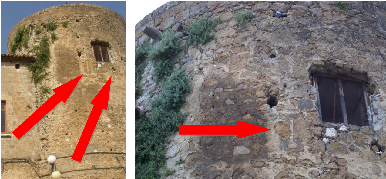
Figura 33. La torre mastio e la coppia di archibugiere verso la piazza (seconda metà del XV secolo).
