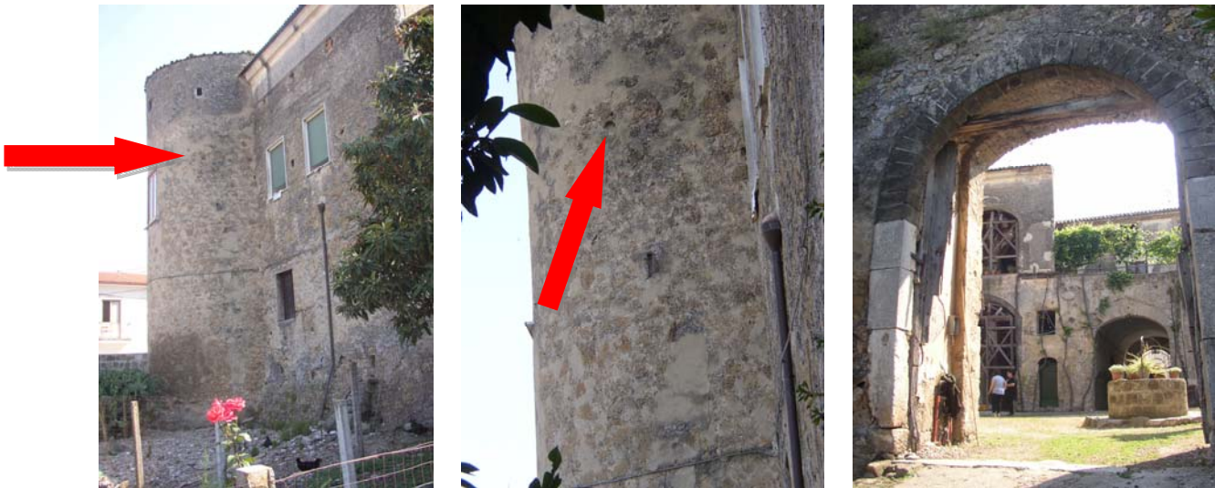
Figura 38. La torre di NO verso il giardino, l'archibugiera (seconda metà sec. XV) e l'arco di accesso dal giardino.
