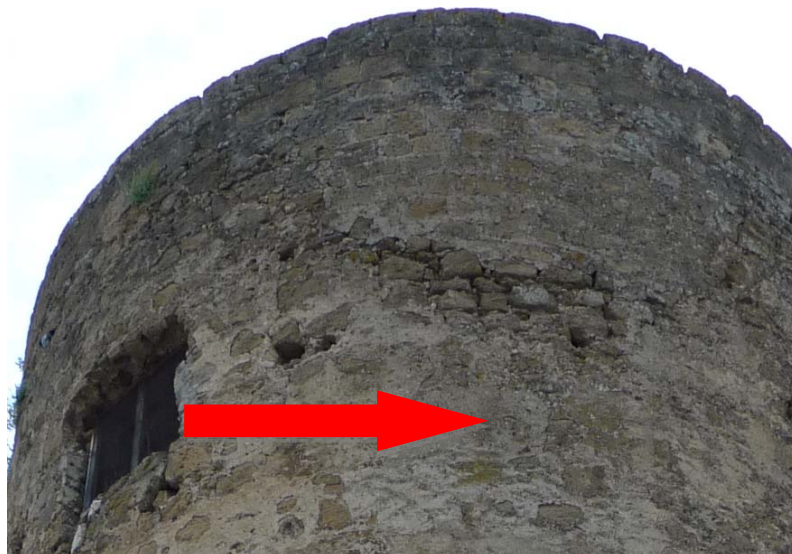
Figura 32. Archibugiera della torre mastio verso la piazza (seconda metà del XV secolo).
