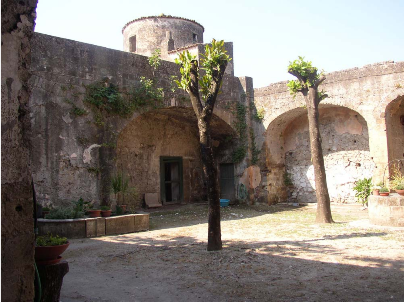
Figura 43. La corte interna verso la torre sud-ovest.
