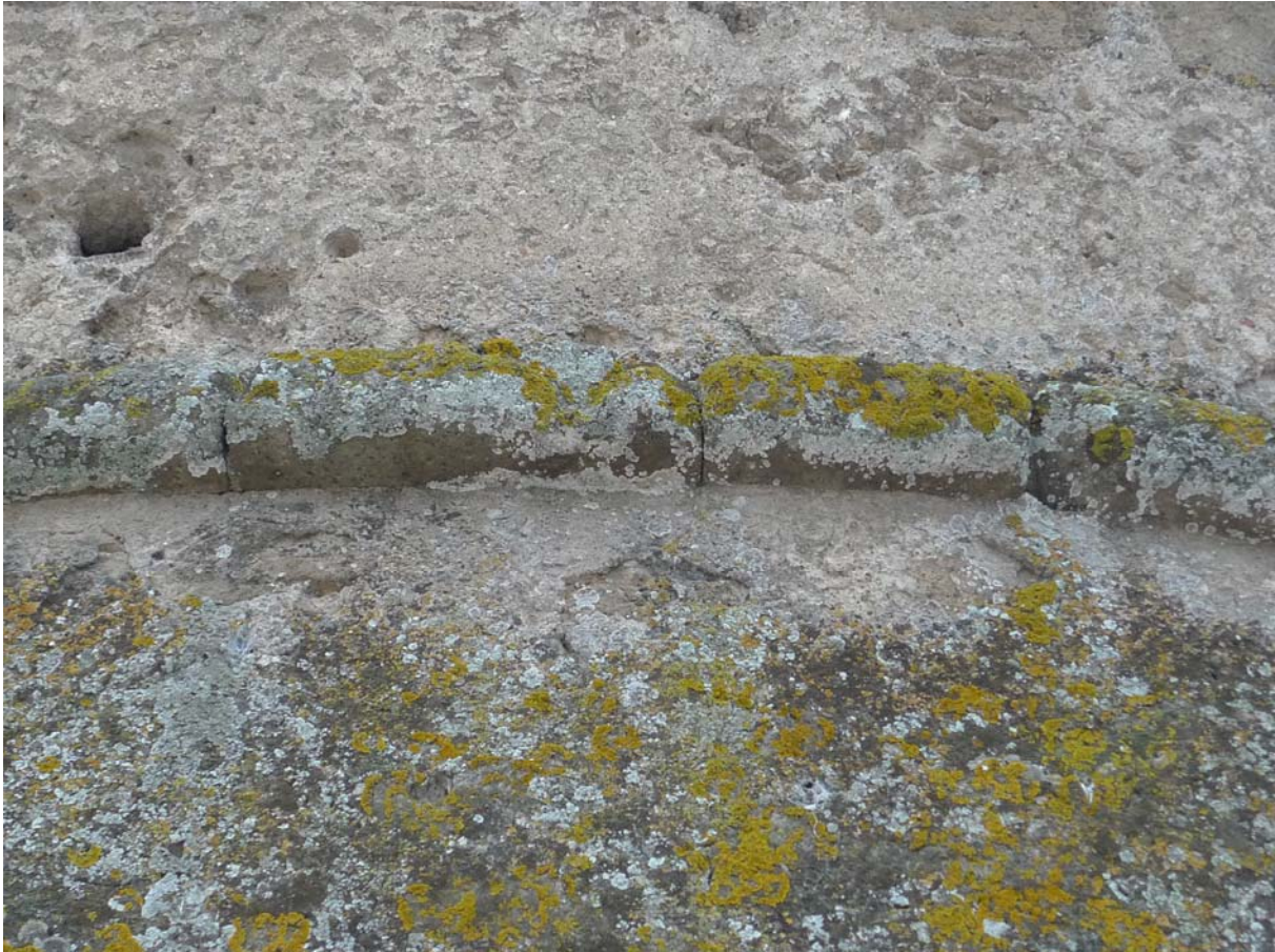
Figura 31. Il redondone della torre mastio (seconda metà del XV secolo).
