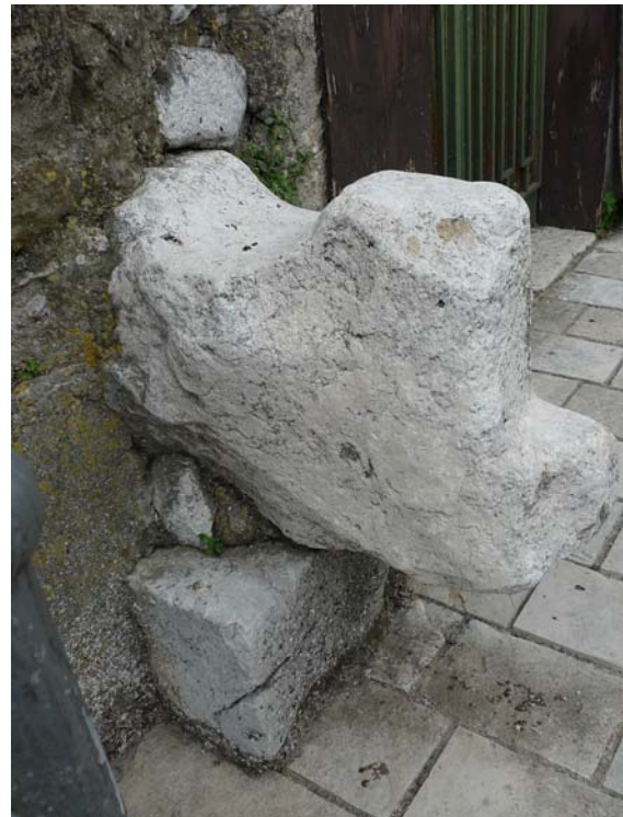
Figura 25. Elementi in calcare per l'appoggio della trave che fungeva da asse del ponte levatoio.
