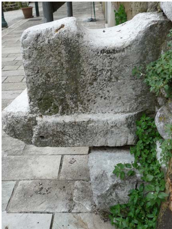
Figura 25. Elementi in calcare per l'appoggio della trave che fungeva da asse del ponte levatoio.
