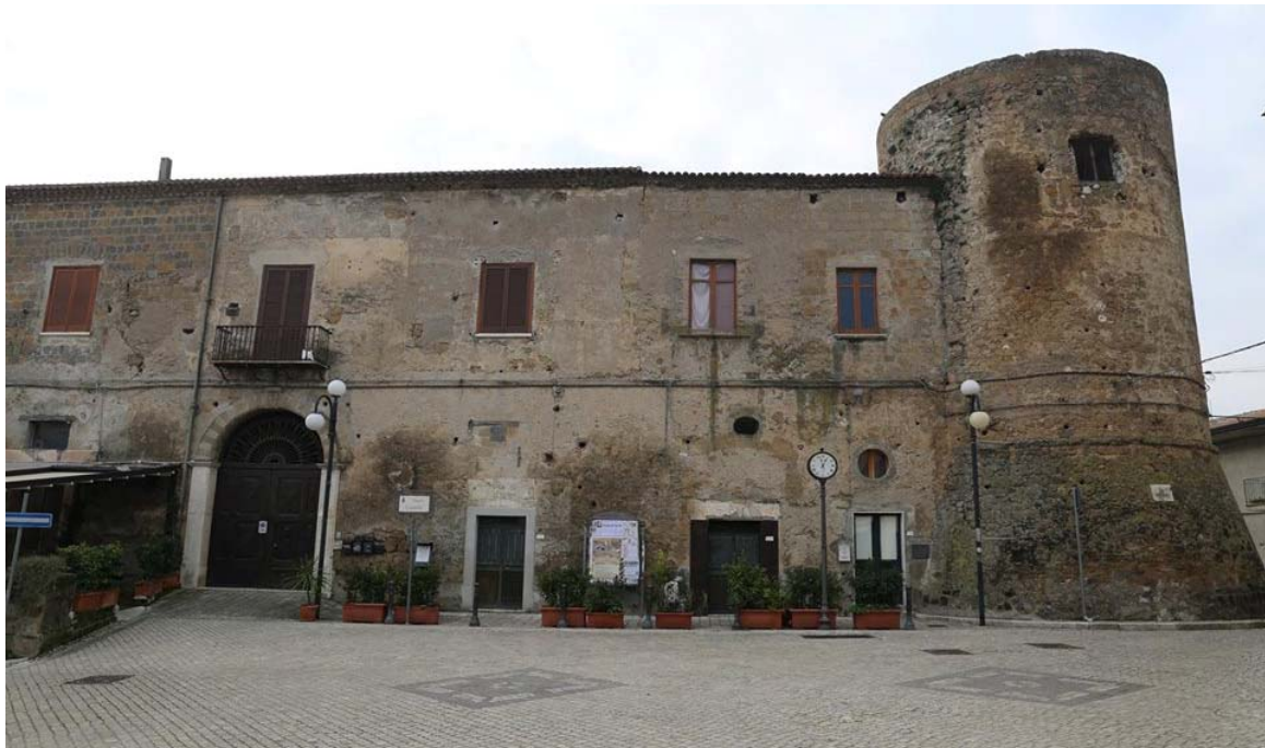
Figura 21. Il prospetto esterno da est con l'ingresso.
