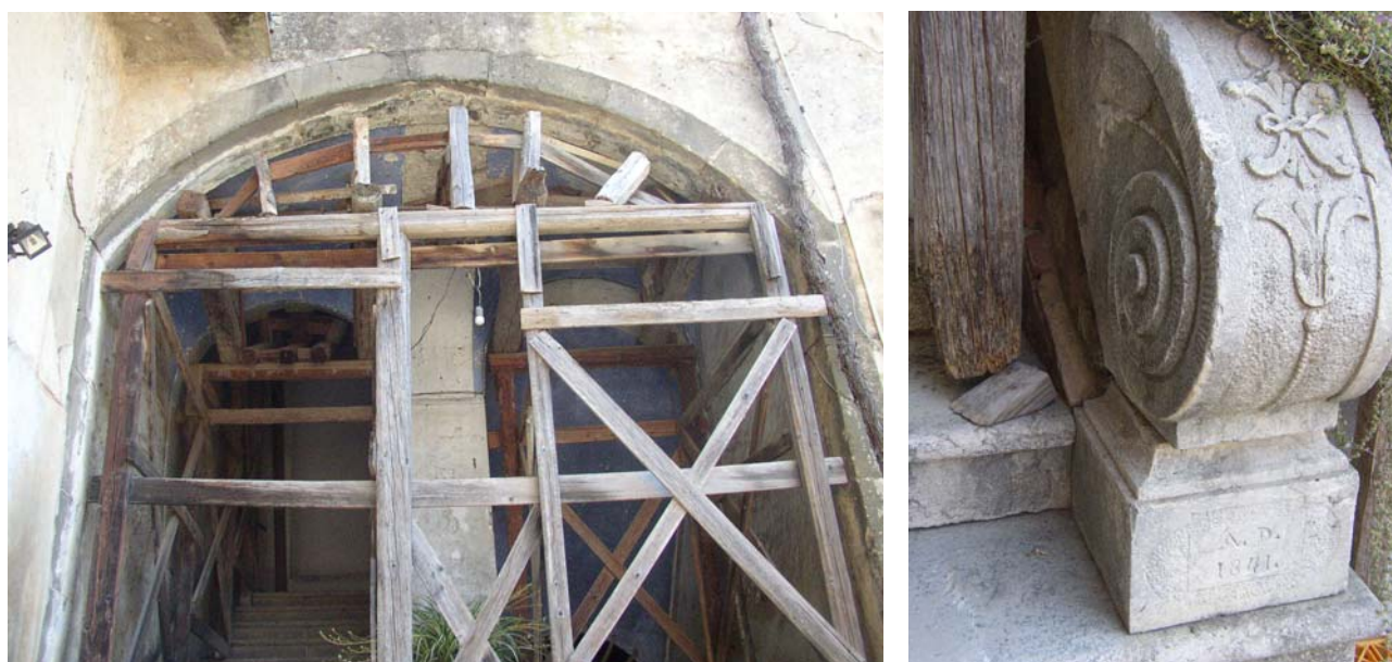
Figura 44. Le volte della scala dalla corte e il particolare decorativo del 1841.
