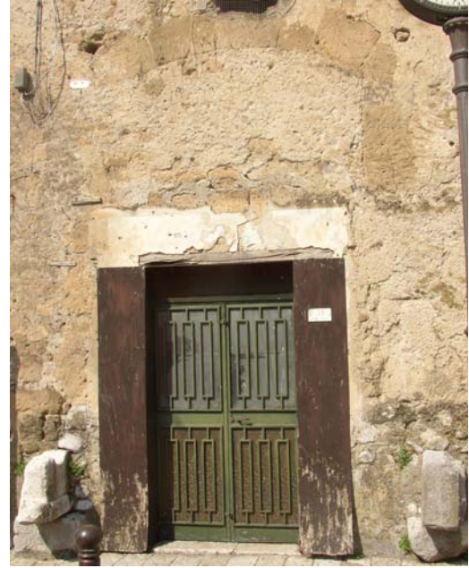
Figura 24. L'antico ingresso con gli elementi in calcare per l'appoggio della trave di perno del ponte levatoio.
