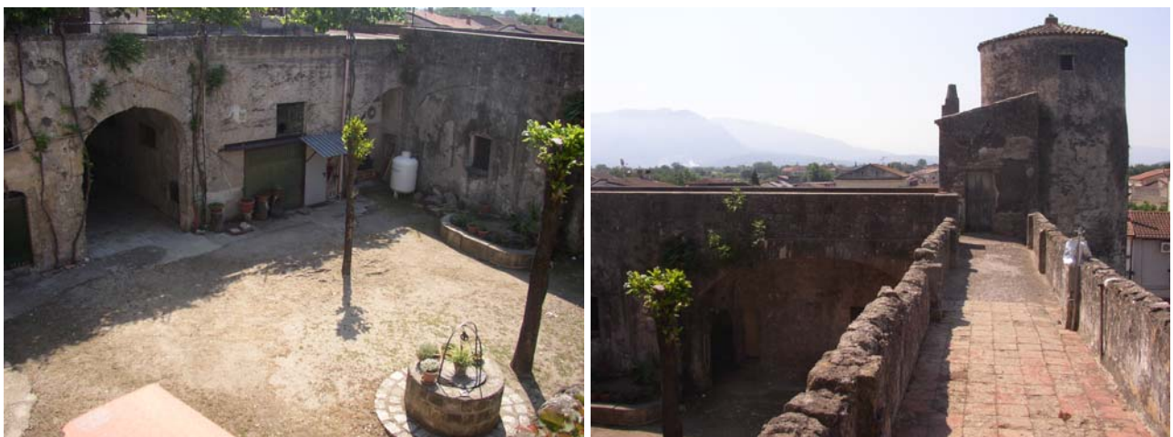
Figura 44. La corte interna verso sud-est e il terrazzo-camminamento sulla cortina ovest, verso la torre S-O.
