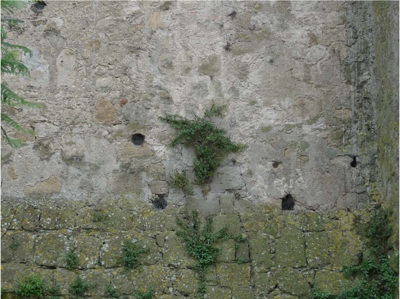
Figura 35. Base scarpata della cortina nord verso la torre di NO.
