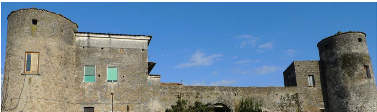
Figura 36. Sopraelevazione e copertura in tegole delle torri di NO e di SO viste dal giardino.
